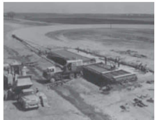
Pouring slab for test bridge.
